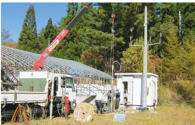
観測装置の引揚げ再設置作業
