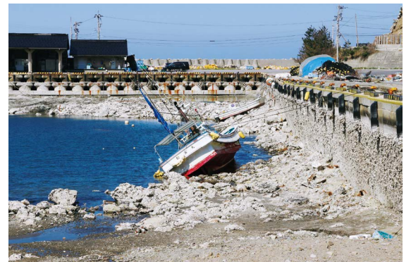
令和6年（2024年）能登半島地震による鹿磯漁港の海底隆起 （平田直顧問提供）
