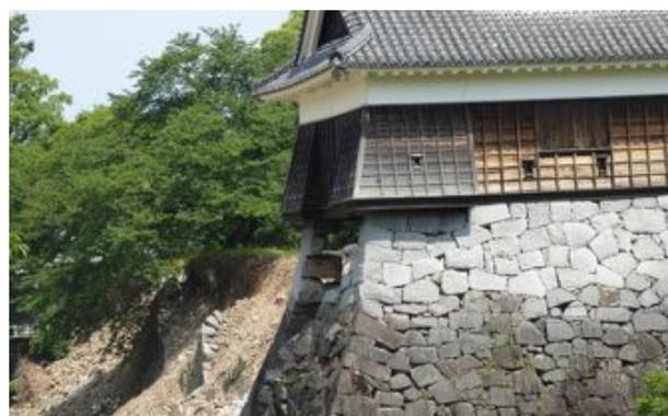
写真2 熊本城飯田丸五階櫓の石垣の崩壊
