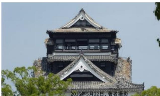
写真1 天守閣の瓦崩落
