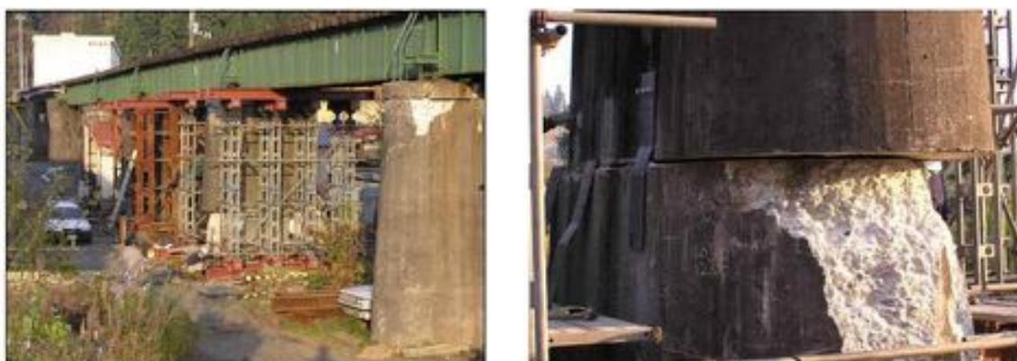
写真1 新潟県中越地震で被災した魚野川橋梁<sup>5)</sup>
