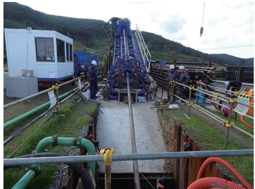
写真1 串間陸上局における誘導式水平ドリル工法による管路の工事風景
