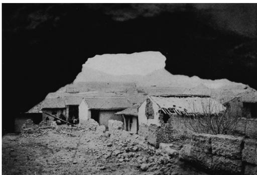
図 10 隆徳と固原の間にある瓦亭における建物の被害状況。一部は修復して利用しているが耐震性のない建物にしては被害が比較的軽く見える（Close and McCormick, 1922）
