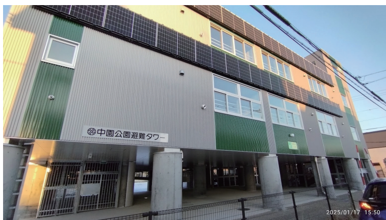
図 5 釧路管内釧路町に整備された津波避難タワー。外壁が取り付けられており冬季も室内が保温される構造となっている
